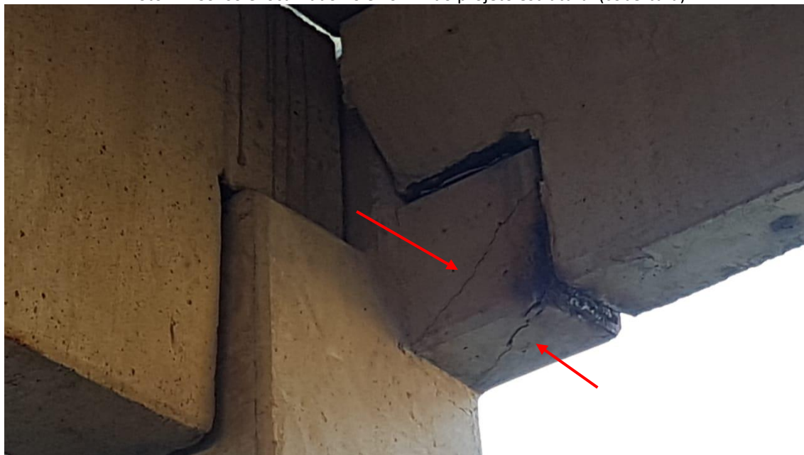
Foto 1 – Console localizado no eixo 1-A do projeto estrutural (cobertura)
