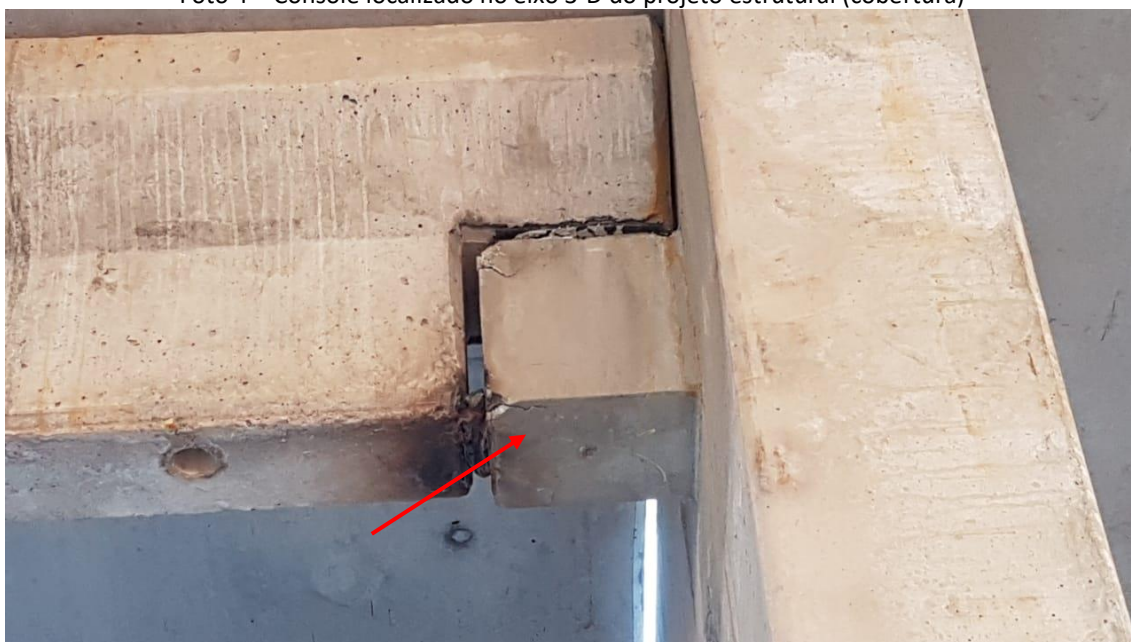
Foto 4 – Console localizado no eixo 3-D do projeto estrutural (cobertura)
