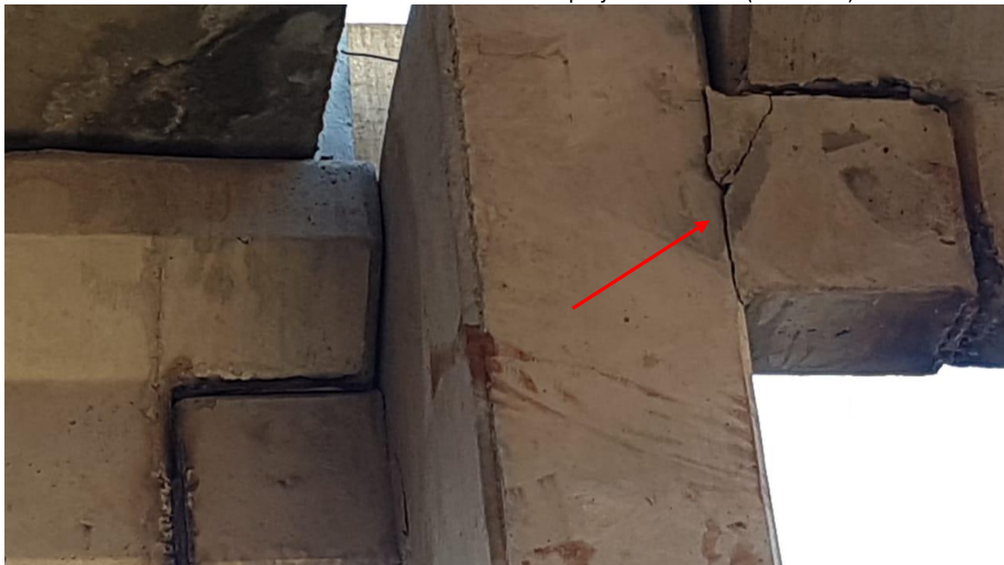
Foto 8 – Console localizado no eixo 2-L do projeto estrutural (cobertura)
