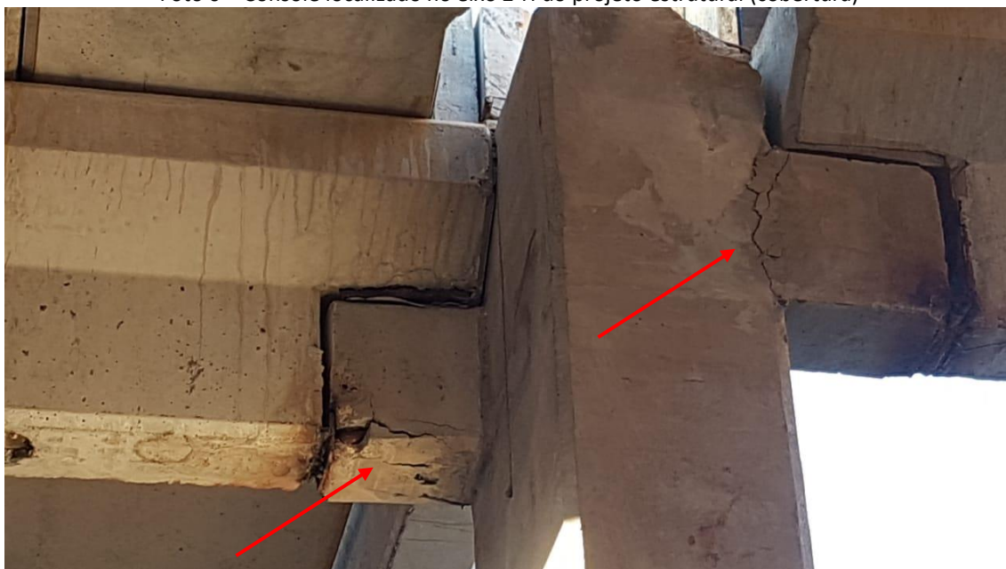
Foto 6 – Console localizado no eixo 2-H do projeto estrutural (cobertura)
