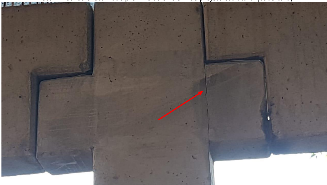
Foto 2 – Console localizado próximo ao eixo 3-A do projeto estrutural (cobertura)
